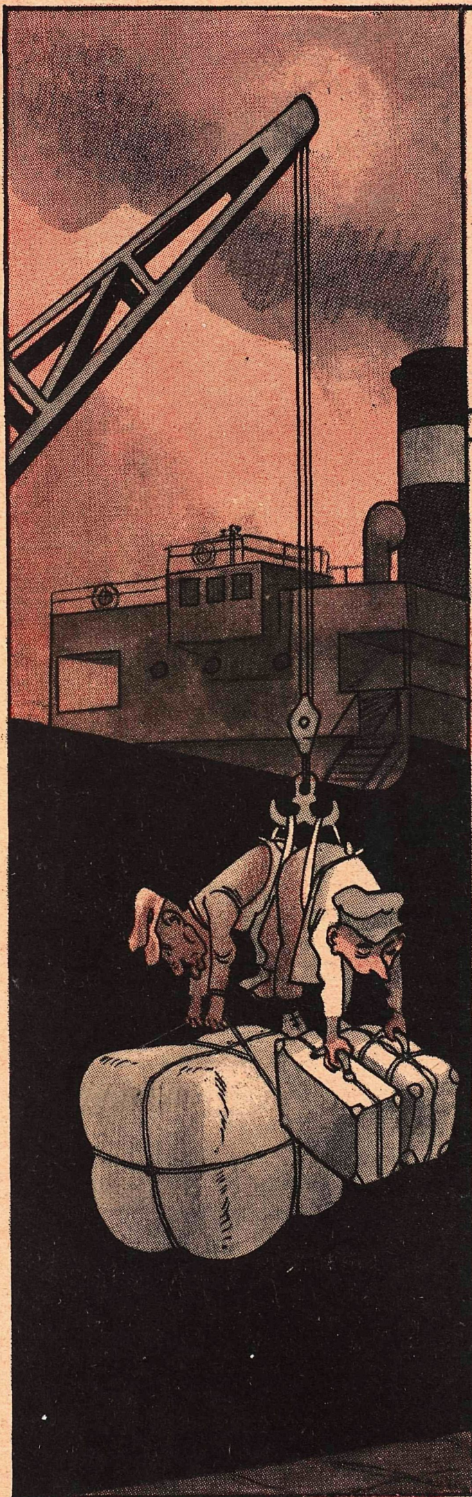
Механизмы, которые используются на водном транспорте неполностью.
